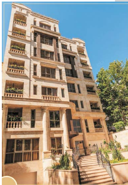
گروه مهندسی اطلس سازه نمونه پروژه آسانسورهای مسافری ۲ دستگاه آسانسور
