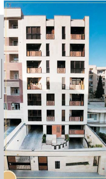
گروه مهندسی ارشیا نمونه پروژه آسانسورهای مسافری ۲ دستگاه آسانسور
